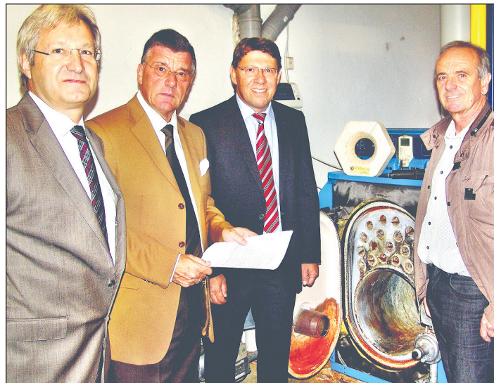
Wiederinbetriebnahme der Heizungsanlage nach erfolgreicher Umrüstung durch Bürgermeister Gerhard Preß (2. v. l.). □
